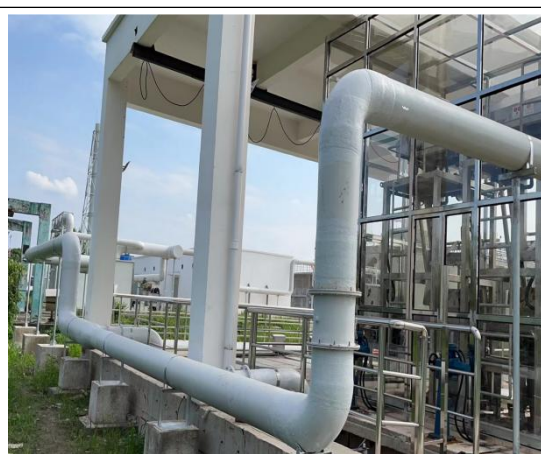
粗格栅密闭及接入除臭系统废气管道
