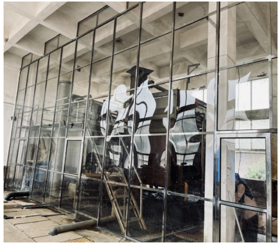
污泥脱水间密闭
