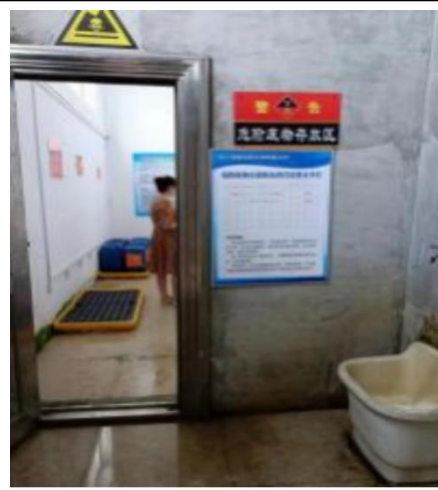
危险废物暂存间
