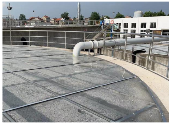
浓缩池接入除臭系统废气管道
