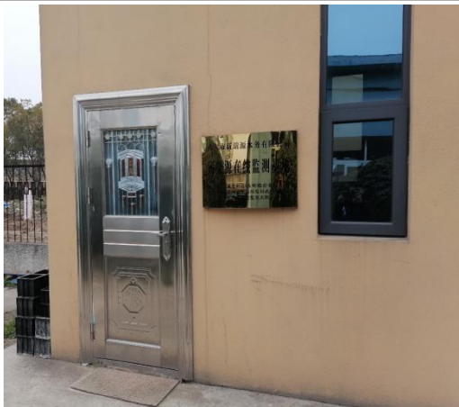
出水在线监测室
