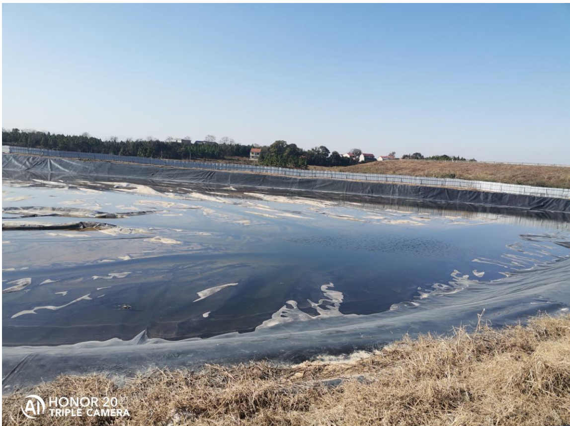
图3-2-5 黑膜沼气池外部示意图
