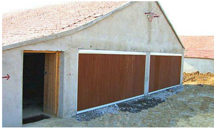
图 2-1 猪舍水帘系统示例图
