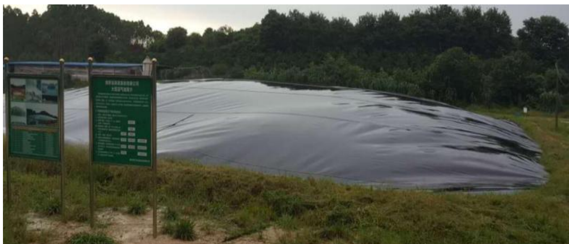
图3-2-10 黑膜沼气池外观图（仅供参考，非本项目）
